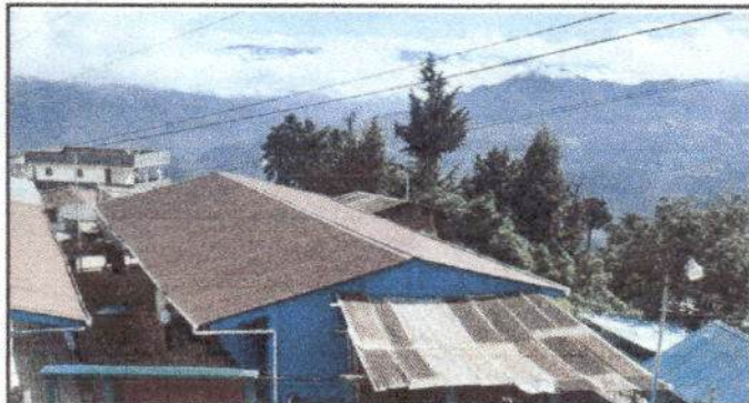
Foto No. 1: Sustrucción de lámina por lámina troquelada aluzinc 26
