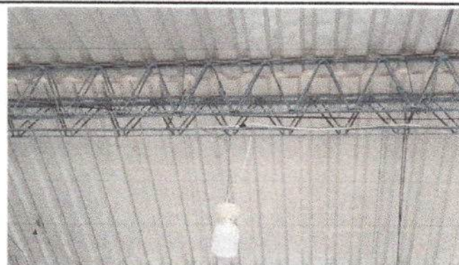
Foto No. 10: Reparación de cableado eléctrico
