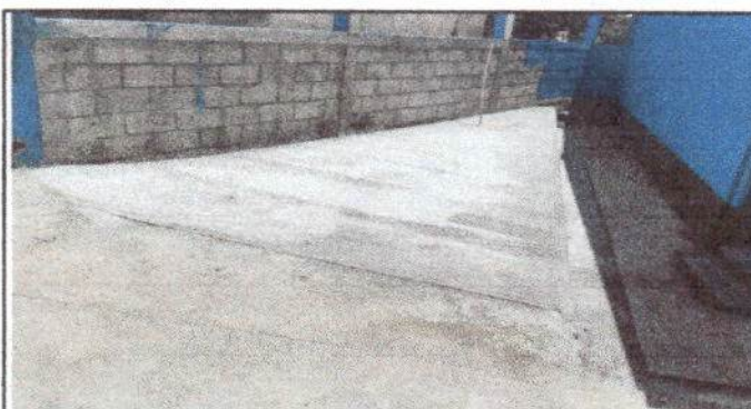
Foto No. 4: Sustrucción de piso de torta de concreto
