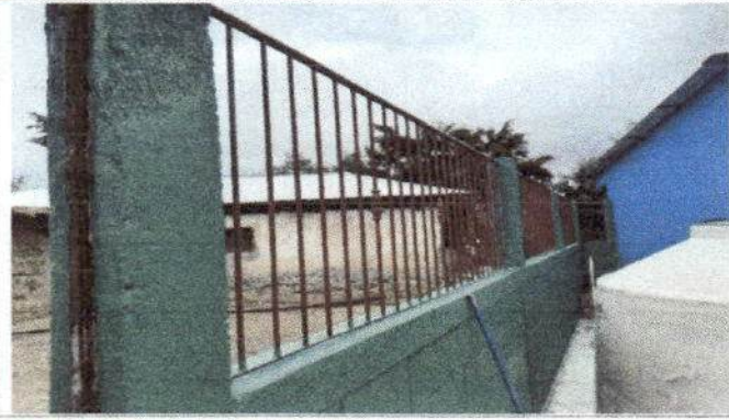
Foto 13: Pintura en muros exteriores
