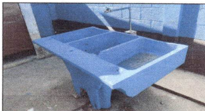
Foto No. 12: Sustitución de pila de cemento de dos lavaderos
