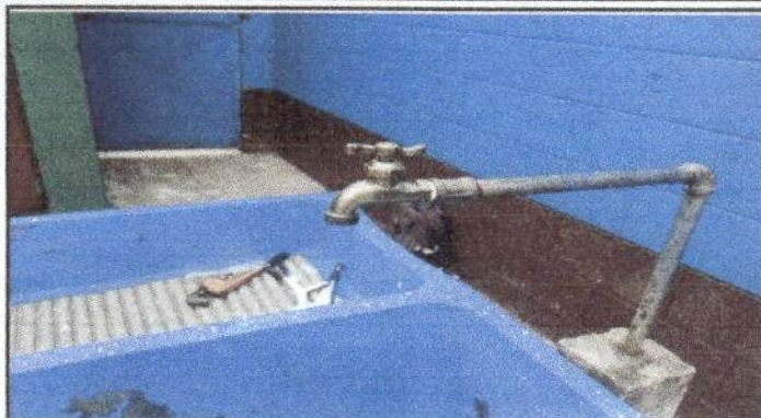
Foto 7: Sustitución de llave de chorro
