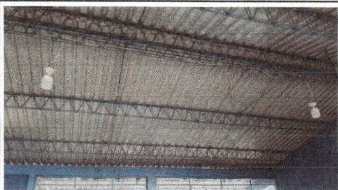
Foto No. 9: Sustitución de plafoneras
