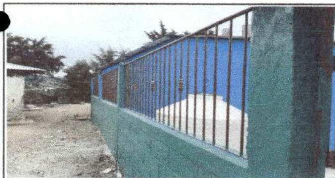
Foto No. 5: Sustrucción de barandas de metal
